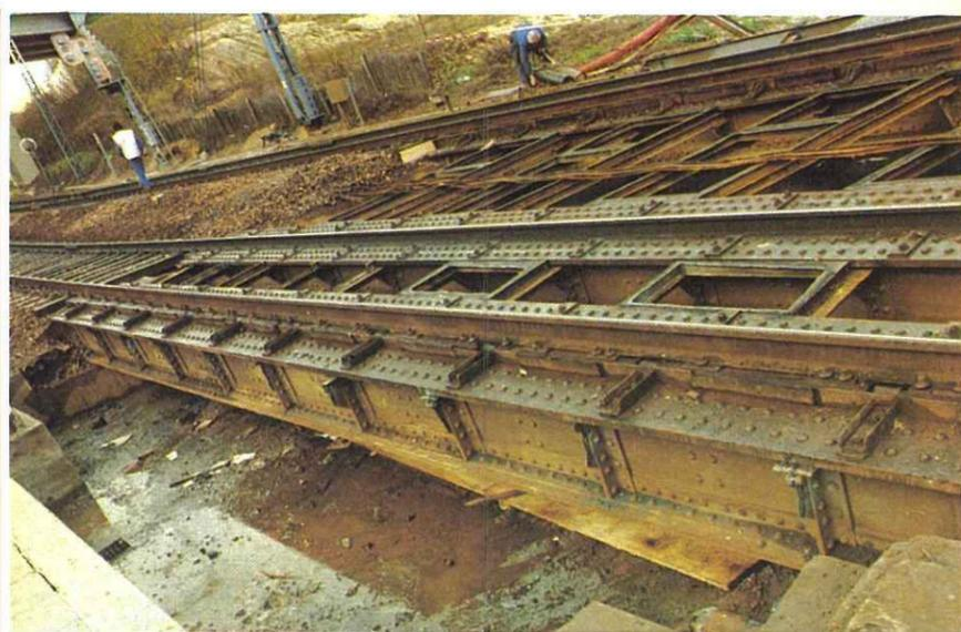
Les tabliers métalliques avant la dépose. Le remblai est en place. Le platelage, les garde-corps et les poutres de rive sont supprimés.
