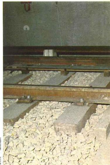
Pose ballast, pose béton. Ce sont ces deux types de voie qui sont actuellement utilisés. La pose béton est employée sur toutes les extensions en souterrain depuis 10 ans. L'une des deux poses ou les deux seront retenues par la RATP pour la modernisation des voies du métro.
