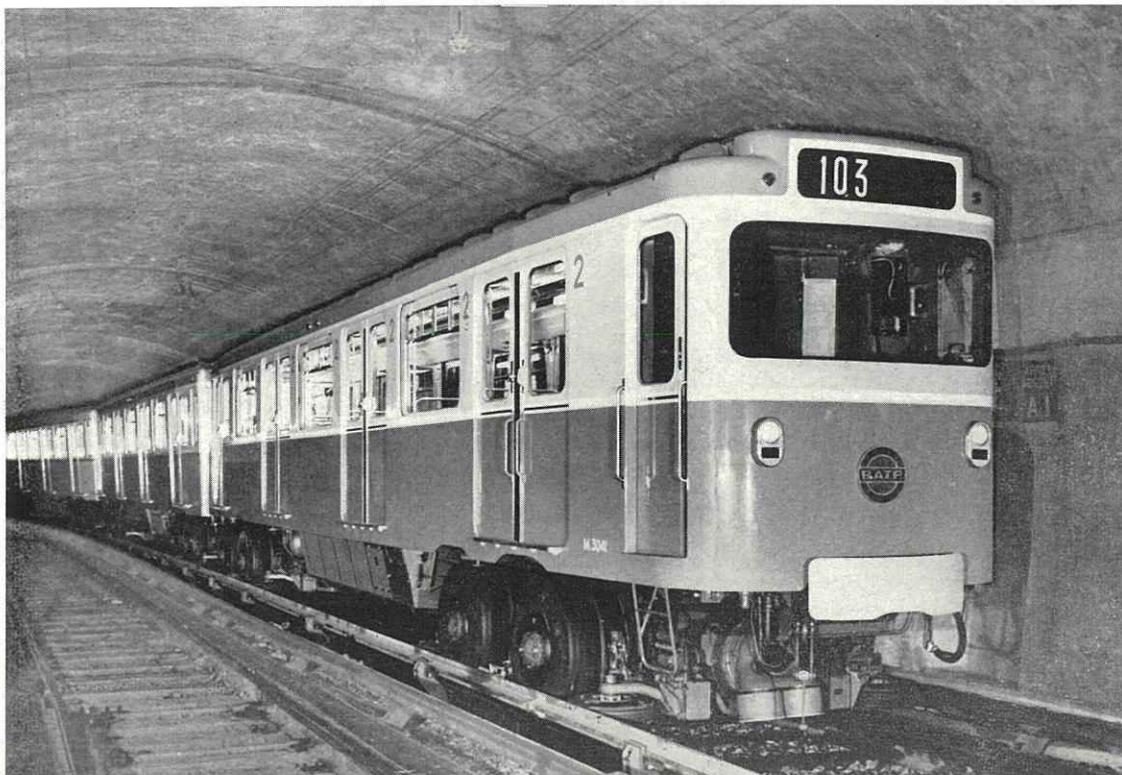
Fig. 1. — Matériel roulant sur pneumatiques
