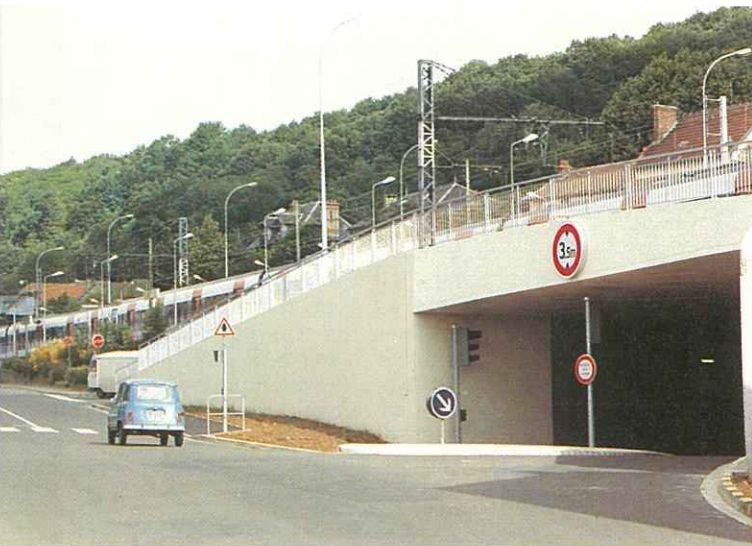
Les ouvrages de remplacement du PN 18 : — à gauche, le passage routier ; — à droite, rampe et escalier d'accès du passage piétons.
