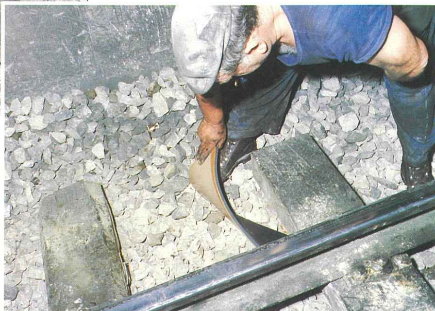
8. Mise en place de semelles sous traverses (ligne 9).
