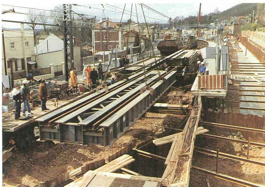
Pose des tabliers auxiliaires après enlèvement de la voie existante afin de permettre l'avancement du passage routier.
