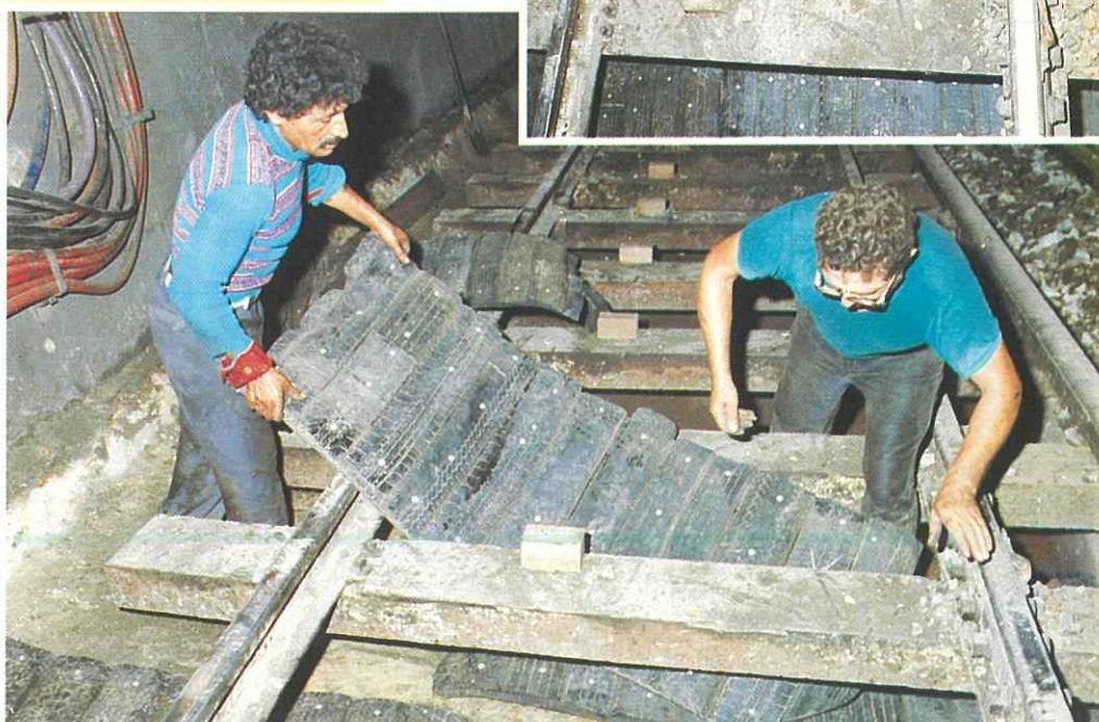
10. Mise en place de tapis composite sous ballast.
