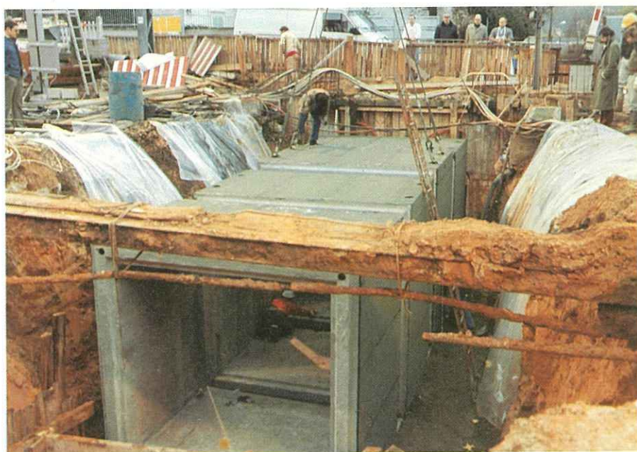
Mise en place des éléments préfabriqués du passage piétons.
