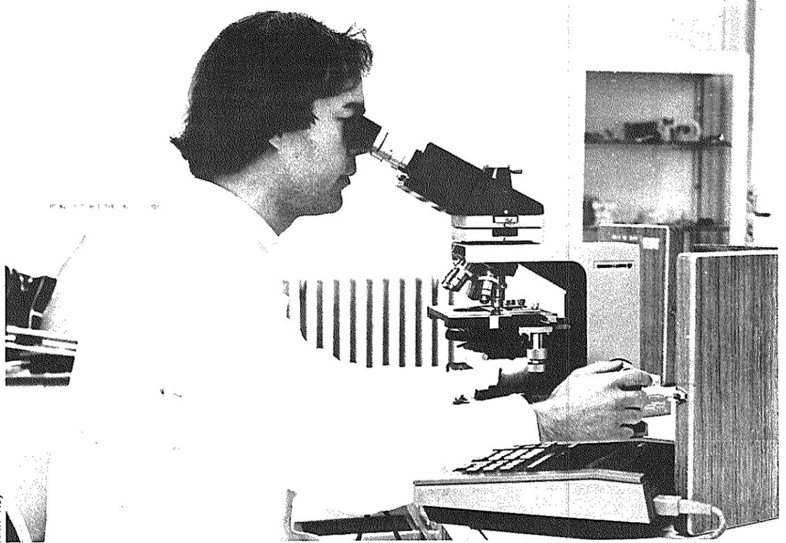
Analyse microscopique de fibres d'amiante.
