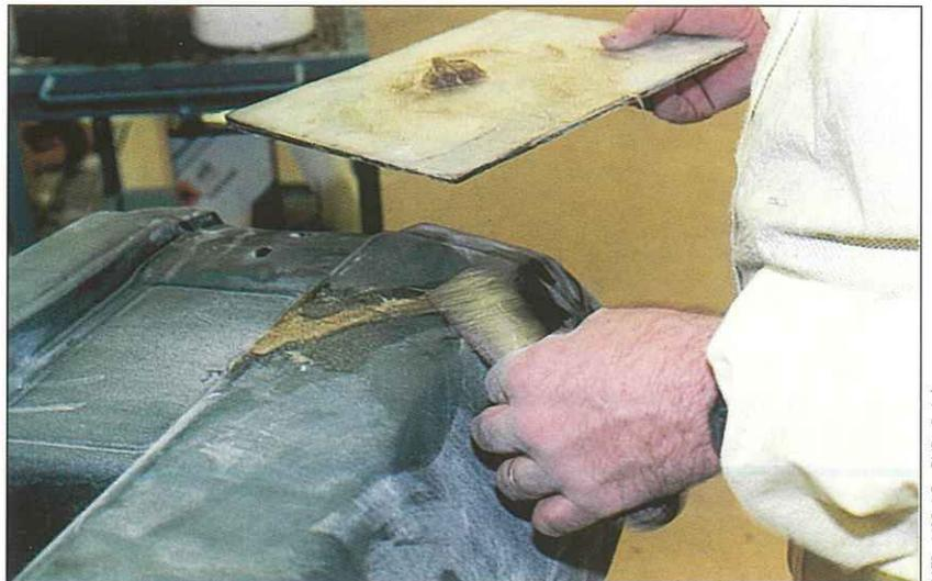
Pose d'une colle armée à la spatule par l'extérieur (dans le cas d'une réparation sans moule).
