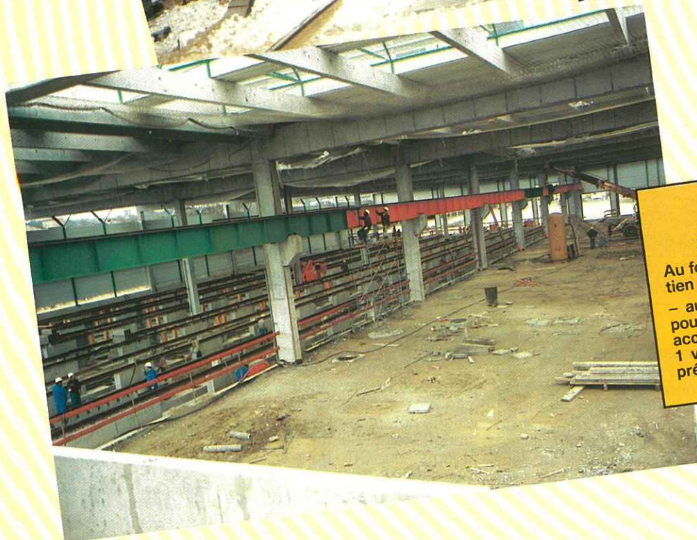
TGV - ATLANTIQUE A FONTENAY-AUX-ROSES Dans la nuit du 29 avril 1987, remise en place initiale des voies et caténaires de la ligne B après déplacement pour travaux du TGV.
