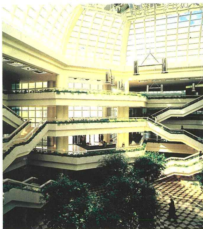
« Challenger », le nouveau siège social de Bouygues à Guyancourt.
