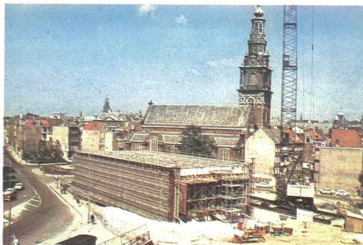
gigantesques « boîtes creuses » longues de 40 m, hautes et larges de 10, construites depuis 1971 au niveau du sol, à 14 m au-dessus de leur emplacement final. Leur fonçage s'effectue en effet sur place. Dès la construction du caisson, qui dure environ 8 mois,
