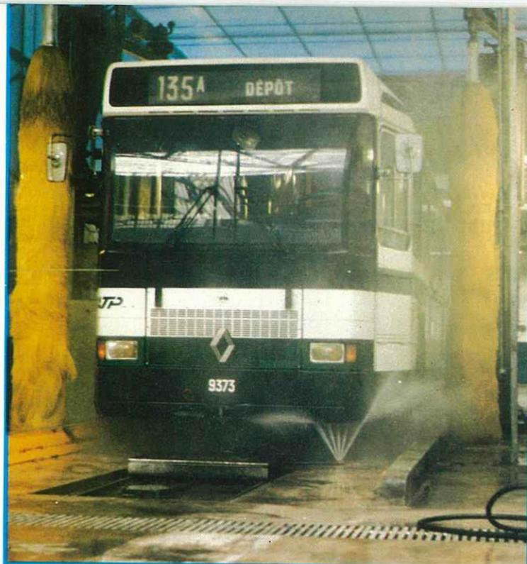
**A**u dépôt d'Asnières, comme dans tous les dépôts du routier, les autobus sont lavés par une machine automatique. Ce n'est pas une nouveauté pour les caisses ; par contre, pour les châssis, c'est une première.
