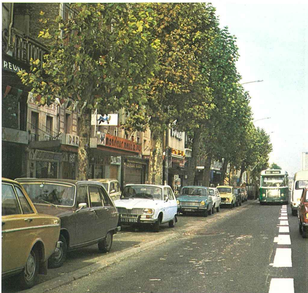
Exemple d'aménagement réalisé avenue de Fontainebleau au Kremlin-Bicêtre (R.N. 7) où coexistent une file de stationnement et un couloir réservé.
