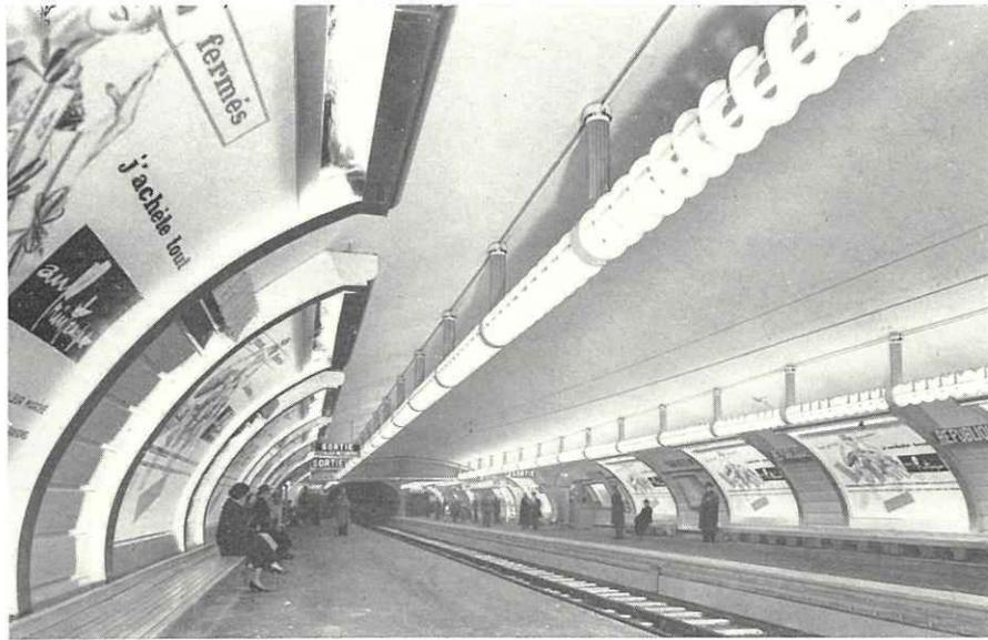
Fig. 9. — « République », ligne 3. Vitrines aux débouchés des accès. Cadres éclairés individuellement, tubes fluorescents encastrés dans le bandeau supérieur des cadres
