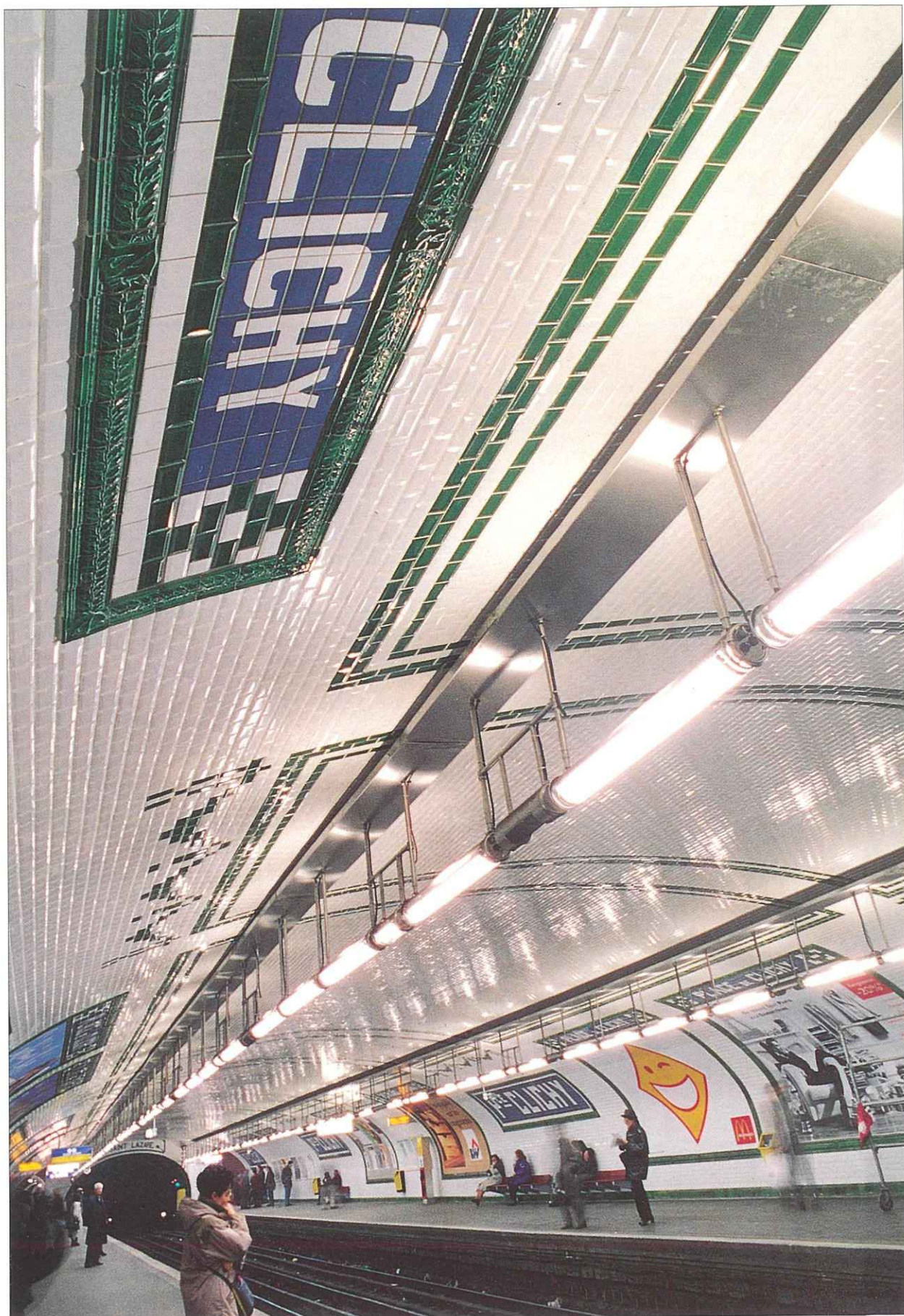
LA STATION "PLACE DE CLICHY" RÉNOVÉE - J. COURROUGE - RATP - COM/AF - 21/02/94
