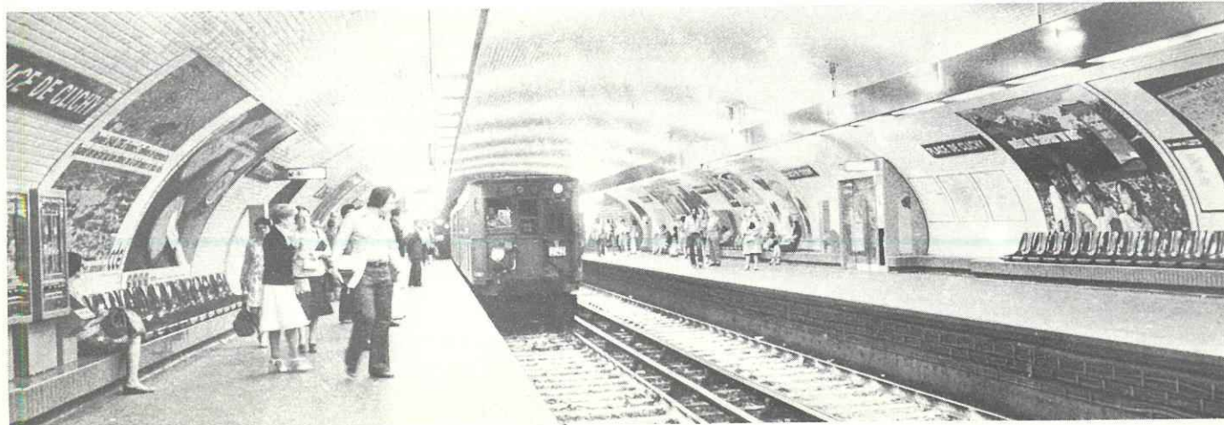
Quais de la station Place de Clichy — ligne n° 2.
