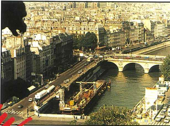
De chaque côté du quai Saint-Michel sur la Seine, quai du Marché-Neuf, le chantier était partout, sous l'œil étonné des gargouilles de Notre-Dame.
