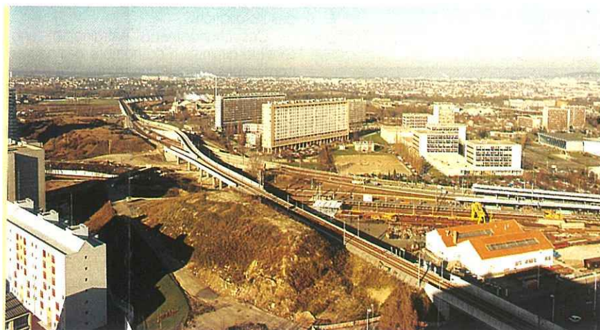
RER. Ligne A. Interconnexion des réseaux SNCF et RATP à Nanterre. Vue générale, partie à ciel ouvert. Raccordement en saut de mouton sur la ligne SNCF de Paris à Cergy-Poissy.
