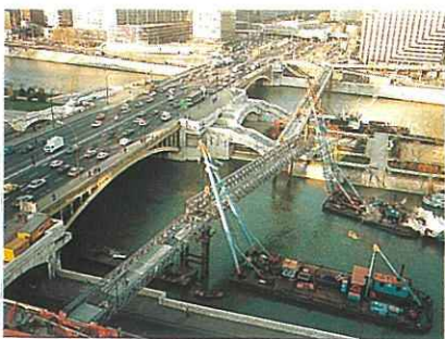
Prolongement de la ligne n° 1 à La Défense. Construction d'une passerelle provisoire en vue des futurs travaux sur le pont.
