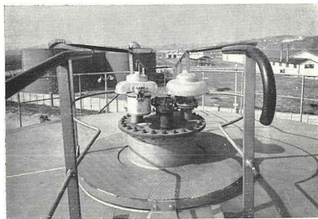
Fig. 7 — Soupapes de respiration.
