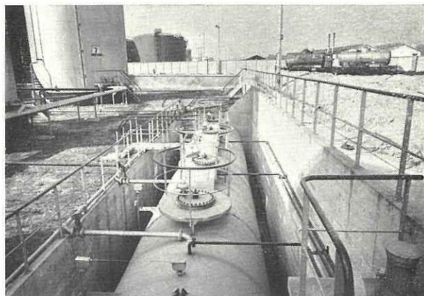
Fig. 5 — Réservoirs de purge.
