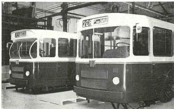
Fig. 1 — Maquettes de l'autobus « standard »
