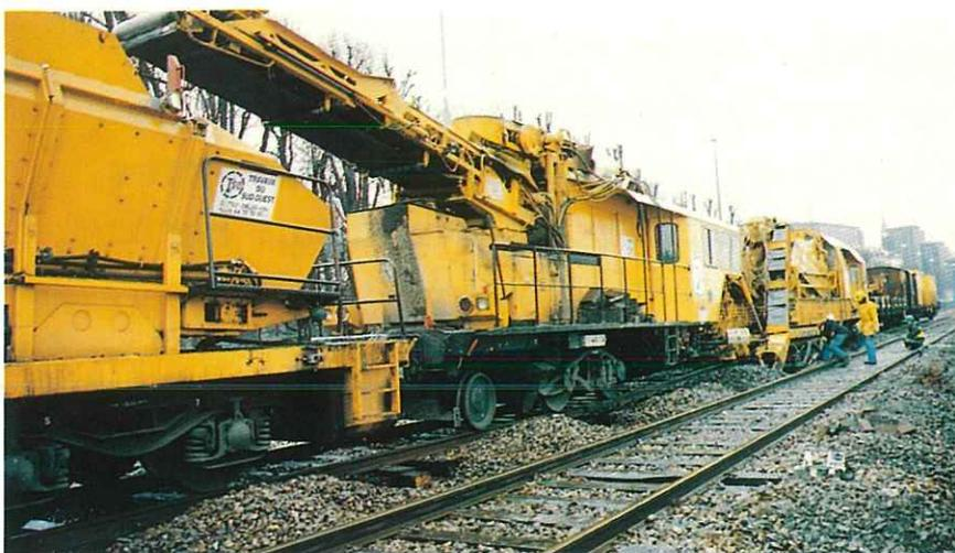
**TVS : le renouvellement complet de la voie (ballast, traverses et rails) entre Puteaux et Pont-de-Sèvres a mis en œuvre un puissant matériel. Ici dégarnissage de la voie à Saint-Cloud.**
