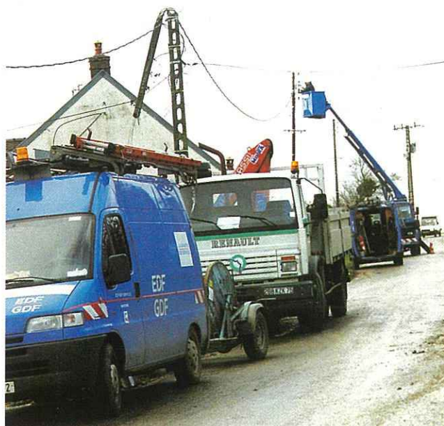
En Seine-et-Marne, à l'aide des camions nacelle, les agents du département ESE ont remonté des lignes pour rétablir le courant.
