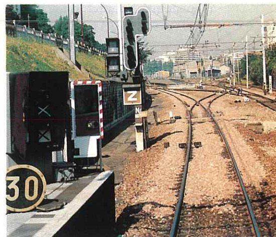
Signalisation en gare de Fontenay.
