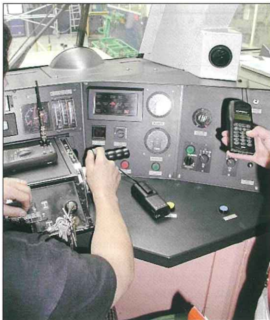
Figure 8. Test réalisé en atelier dans la cabine de conduite d'un train MI2N.
