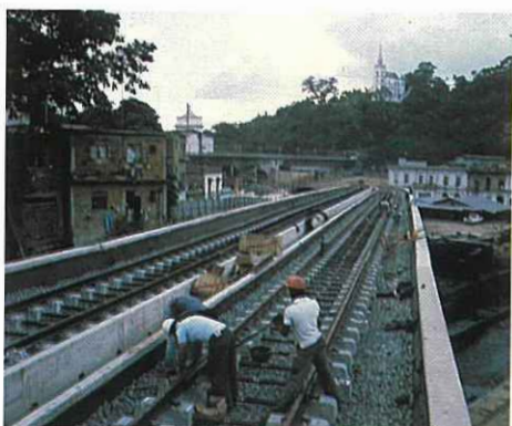
Caracas, pendant les travaux.
