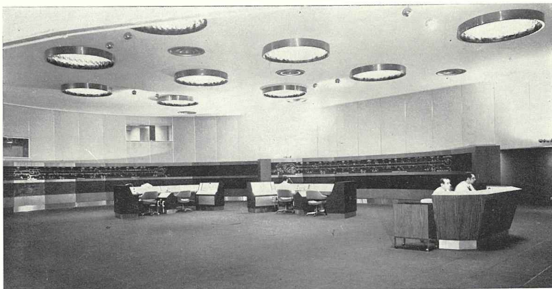
Vue d'ensemble de la salle n° 2 du P.C.C. Bourdon. De gauche à droite les lignes n°s 5, 2 et de Sceaux.
