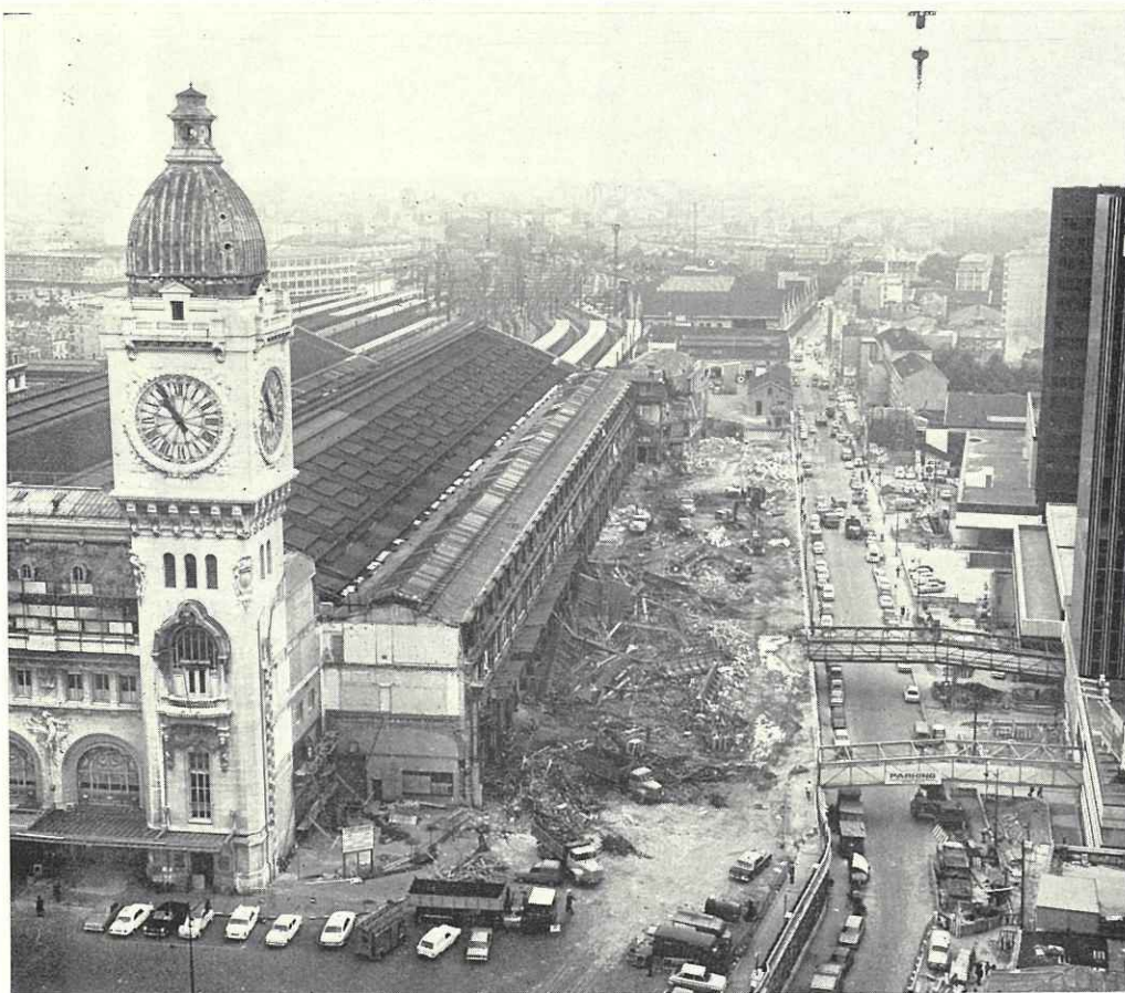
Démolition de halls de la gare de Lyon, le long de la rue de Bercy, pour la construction souterraine de la station du métro régional et de la nouvelle gare de banlieue S.N.C.F.
