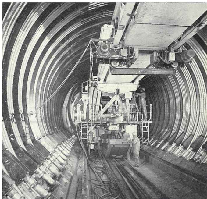
Machine à forer « pleine section » Robbins. Vue arrière.
