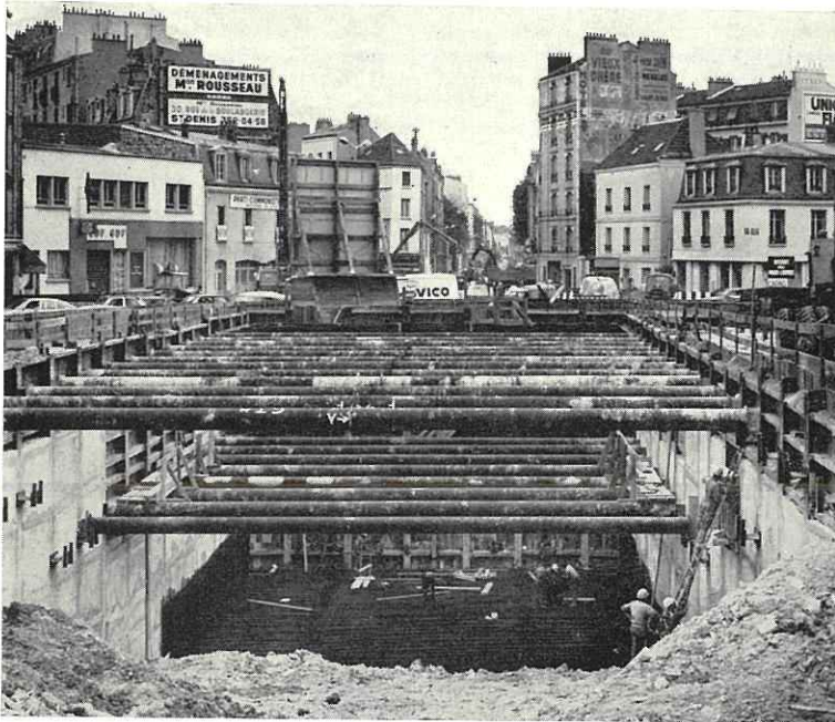
Chantier de la station PORTE DE PARIS, construite à ciel ouvert.
