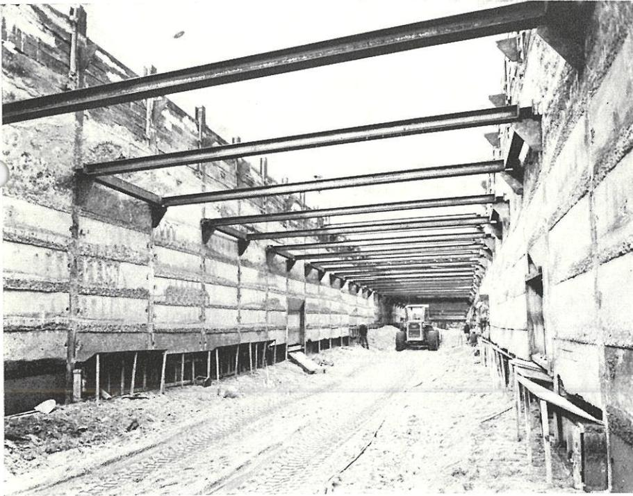
Vue de la fouille protégée par un blindage contrebuté par des étrésillons.
