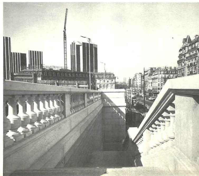
Reconstruction du mur du parvis de la Gare de Lyon
