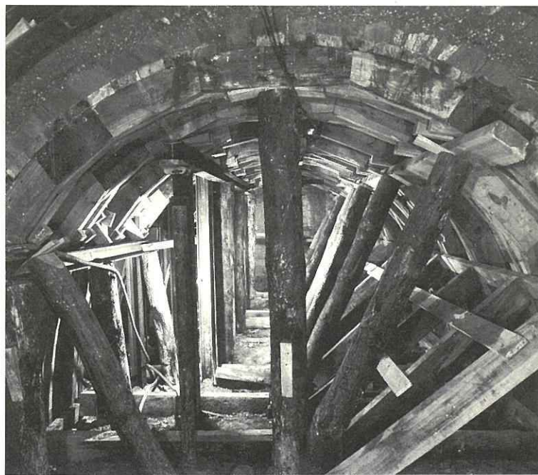
Ligne n° 7 - Chambre de départ du souterrain : blindages et coffrages spéciaux.
