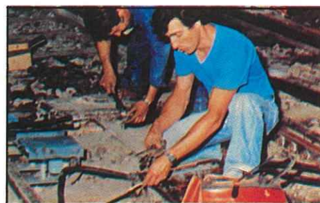
Remettre en état les voies.
