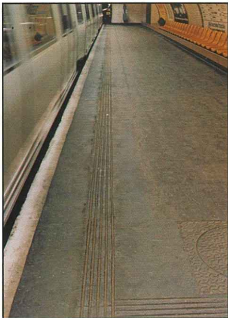
Parmi les essais : ceux de rainurage de l'asphalte.
