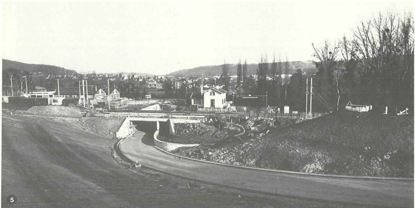
RATP - Travaux neufs
