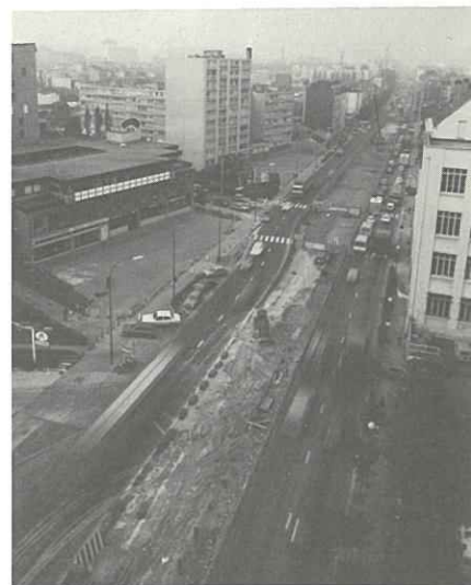
RATP - Travaux neufs
