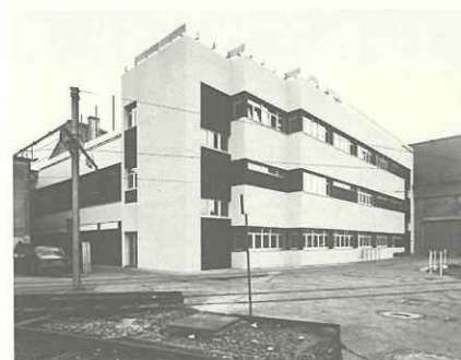
RATP - Travaux neufs
