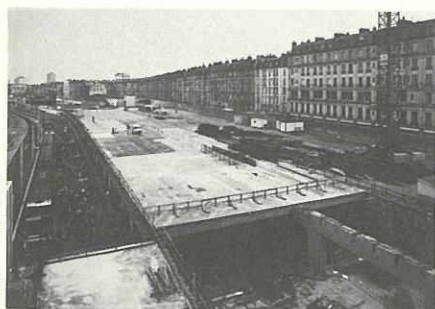
Niveau supérieur: dalle routière en construction
