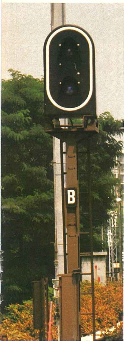
en 1983. Ces nouveaux panneaux permettent la présentation des nouvelles indications, la pose des plaques repères et des téléphones.
