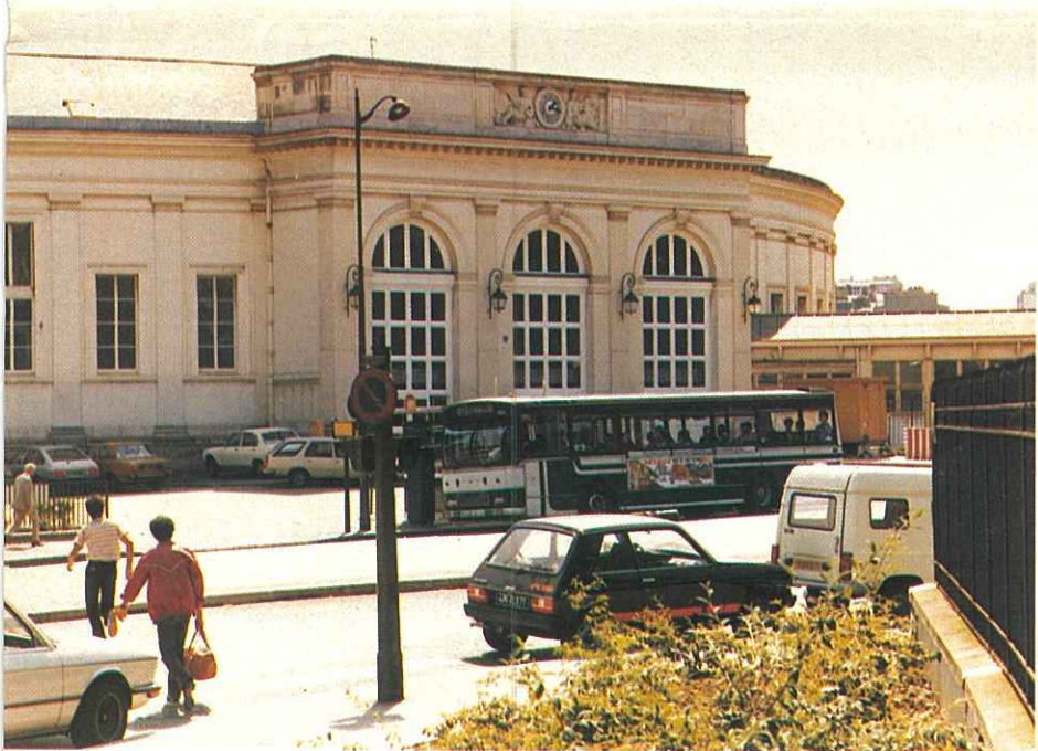
Fin 1981, commenceront les travaux de construction du futur PCC qui sera construit sur le plateau de la gare de Denfert-Rochereau et dont la mise en service est prévue fin 1984.
