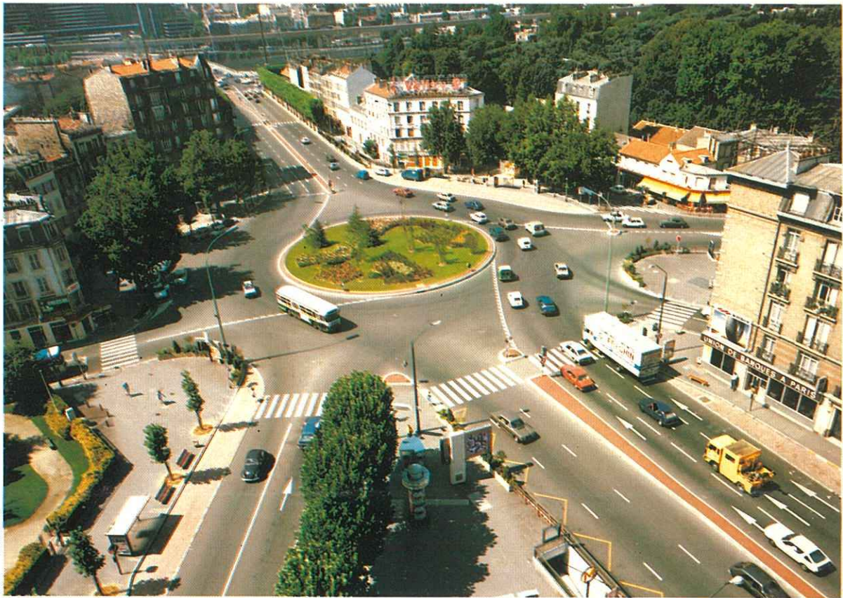
La place Rhin et Danube : les accès sont distribués autour de ce rond-point qui a été complètement réaménagé à l'occasion du prolongement de la ligne 10.
