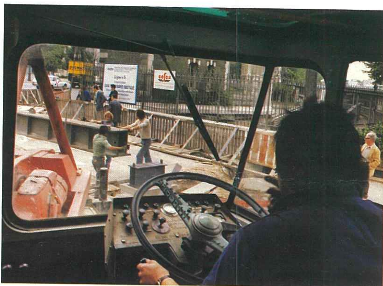
Des travaux de réparation de la couverture métallique, indispensables pour assurer l'étanchéité, dans l'interstation « Quai de la Rapée-Bastille » sur la ligne 5 — travaux auxquels on procède ponctuellement sur tout le réseau — vus de la cabine d'une grue de chantier.
