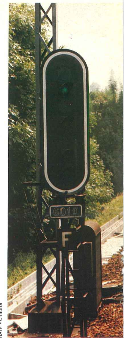
Entrepris en 1977, le changement de signalisation — passage au code SNCF — qui était une condition sine qua non de l'interconnexion, sera achevé
