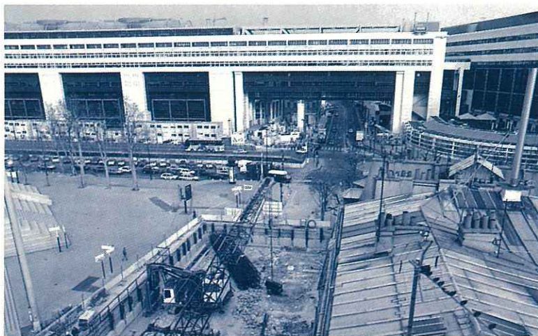
Le chantier de la future station Bercy. Les travaux de terrassement et la réalisation des parois moulées sont en cours.
