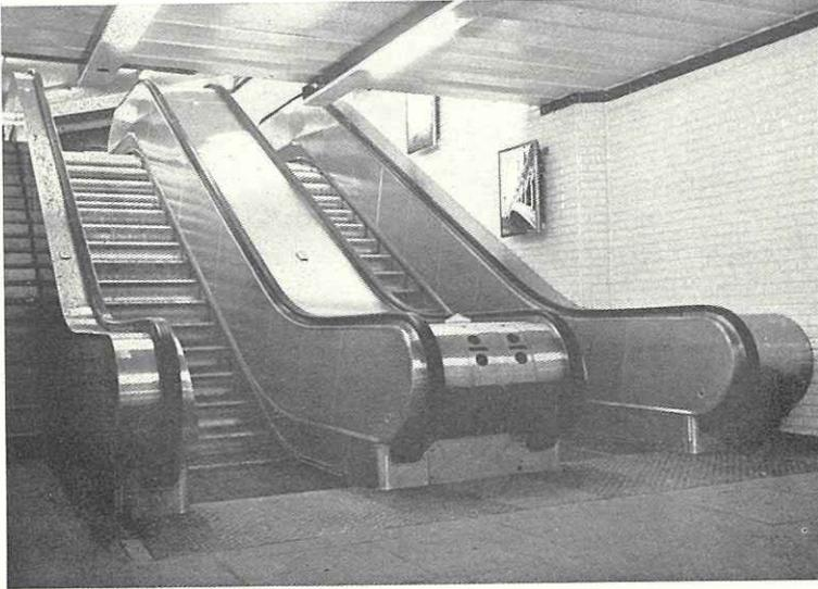
Ces appareils élévateurs, complétés par un escalier fixe latéral, font communiquer le niveau du quai, direction « CLIGNANCOURT » de la ligne n° 4 avec celui de la salle souterraine de correspondance de la S.N.C.F. (agrandie en 1965). L'installation de ces appareils a nécessité une modification assez importante du gros œuvre.
