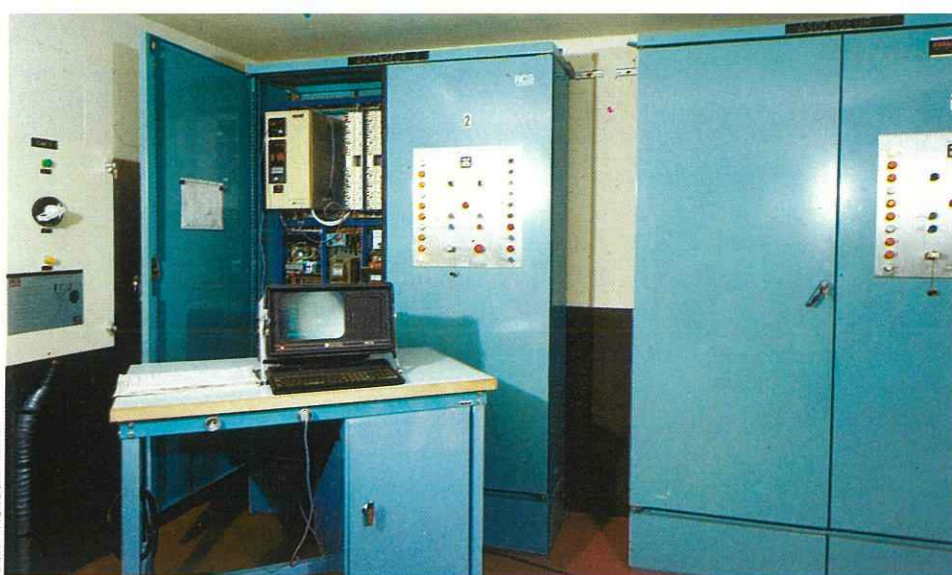
La console de programmation et, dans l'armoire, le contrôleur programmable équipé de son unité de dialogue et de test.
