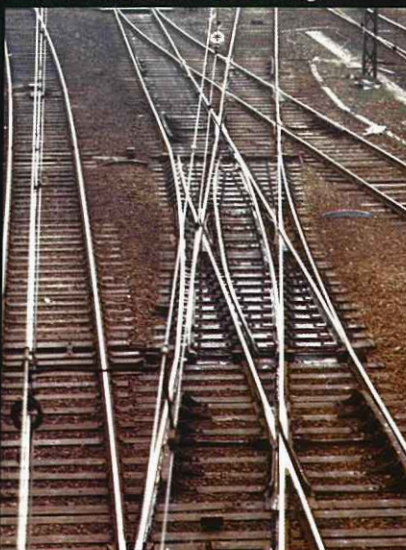
4 - Sur le terrain, les aiguilles mobiles des appareils de voie venaient se placer dans la bonne position, traçant ainsi l'itinéraire du train.
