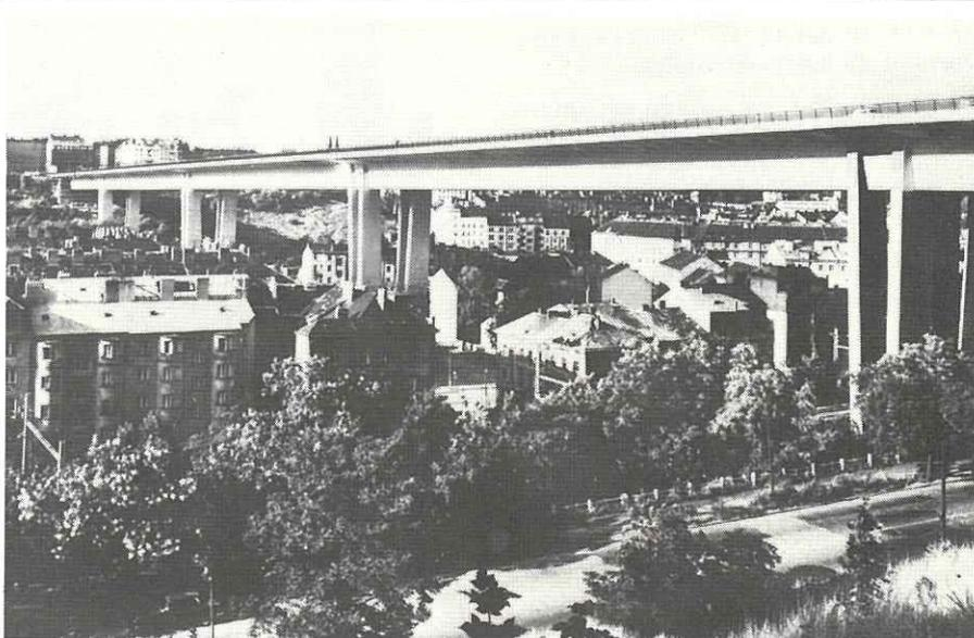
Viaduc rail-route de la Nusle (Pont Klement Gottwald). Les trains du métro circulent dans la partie inférieure.
