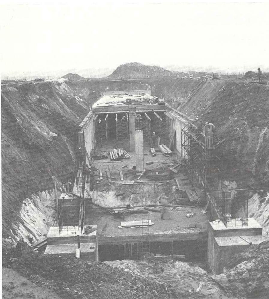
La station « GARE SNCF » longue de 100 m est l'ouvrage principal de la ligne ; elle a 30 m de largeur, 3,50 m de hauteur et comporte dans son axe des poteaux distants de 15 m. Les quais, comprenant 5 positions d'arrêt, seront desservis à leurs extrémités par des accès équipés d'escaliers mécaniques. La largeur de chaque piste, au droit des quais, permettra aux autobus arrivant ou partant de doubler les voitures à quai.
