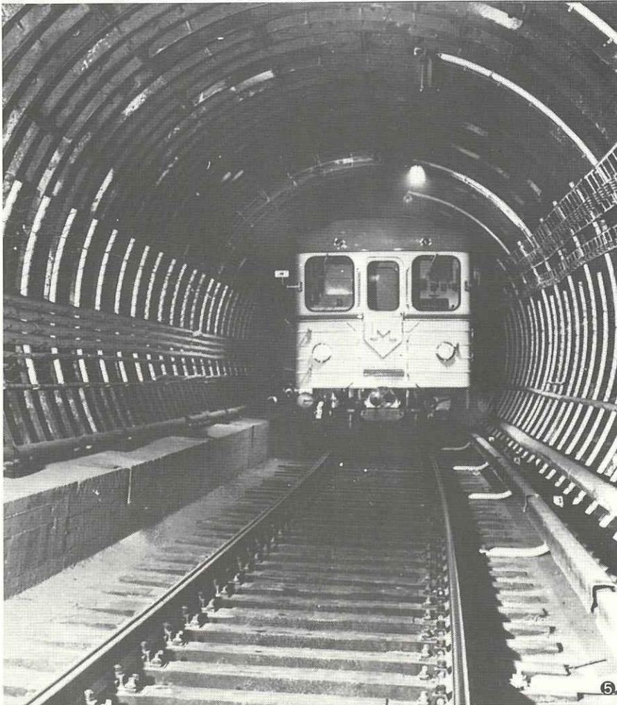
nature géologique du sous-sol, soit par la méthode des parois moulées (tunnel à voie double à section rectangulaire de 9,90 m de largeur), soit à l'aide d'un bouclier (tunnel à voie unique à section circulaire, avec voussoirs en fonte, de 5,10 m de diamètre).
