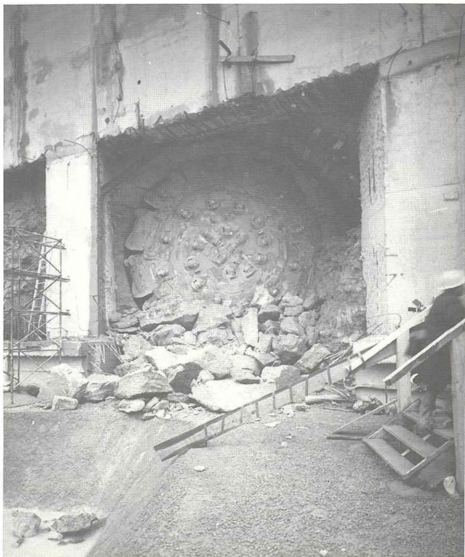
*Débouché de la machine Robbins dans la fouille de la station Châtelet.*
