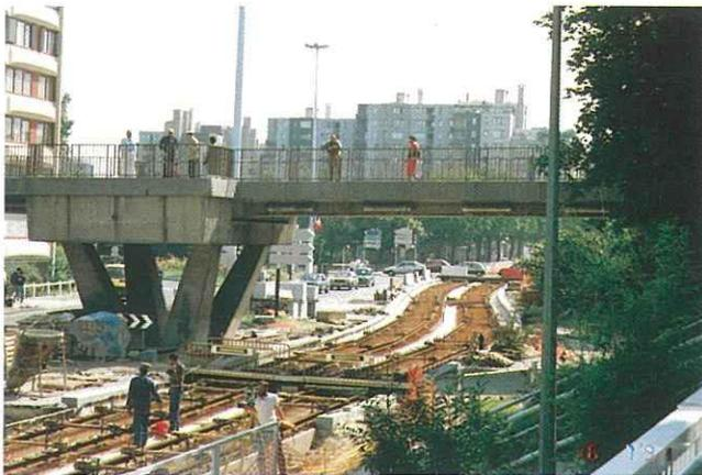
4- Réglage altimétrique et planimétrique des rails (le tableau ci-dessous donne une idée de la précision demandée pour assurer un roulement le plus confortable possible)
