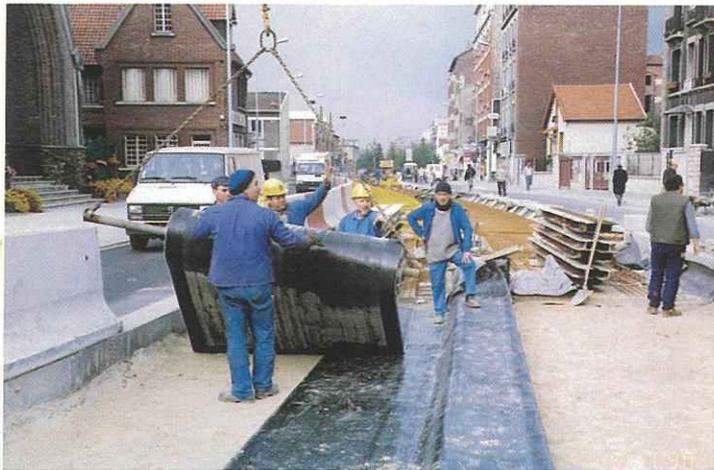
1- Mise en place sur le fond de fouille et les parois verticales d'un matériau isolant protégé par un béton de propreté
