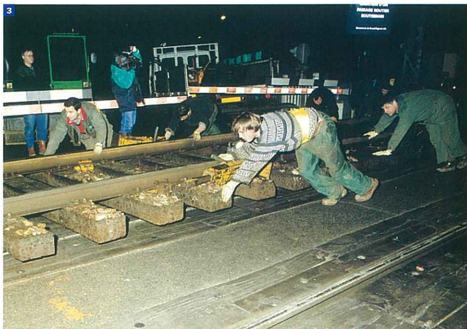
▲ 23 mars : 1 heure 30 à 4 heures 30 : les équipes d'ITA et de ESE déposent les voies et les signaux. Jusqu'à 12 heures, 1 000 m³ de terre sont excavés pour laisser place au passage souterrain.
