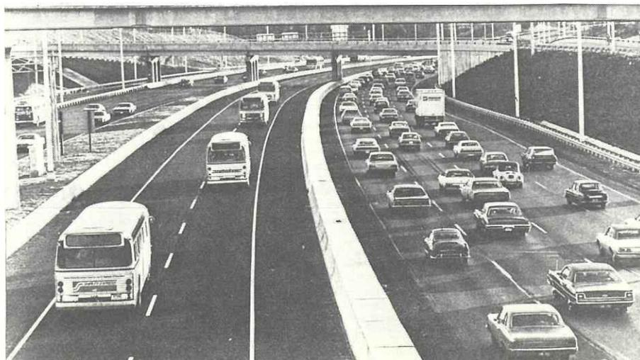
en évidence l'intérêt des couloirs de circulation réservés exclusivement aux autobus. Il est à noter que le couloir représenté est totalement isolé des autres voies de circulation, d'un côté par la plate-forme séparant les deux flots de trafic, de l'autre surtout, par une bordure interdisant tout empiètement et permettant ainsi une progression rapide.
