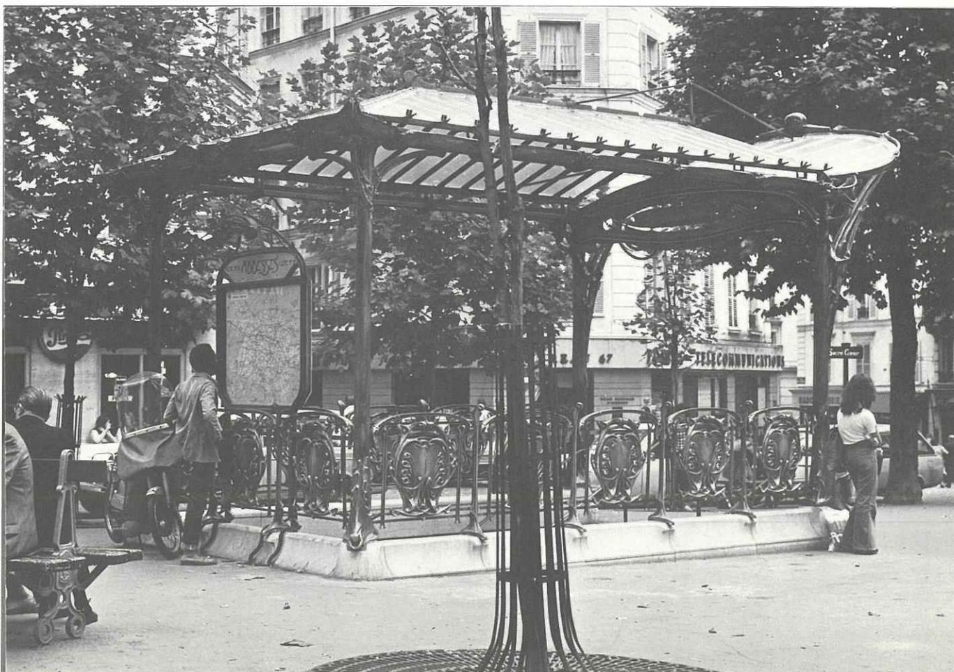
PHINE, il comporte, outre sa toiture, une fermeture complète sur trois côtés. L'autre qui était installé rue Lobau, derrière l'Hôtel de Ville, à la station HÔTEL DE VILLE, ne comprend qu'une toiture vitrée supportée par une charpente, soutenue elle-même par quatre colonnes de fonte.
