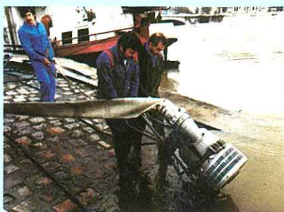
Mise en place des pompes auxiliaires.
