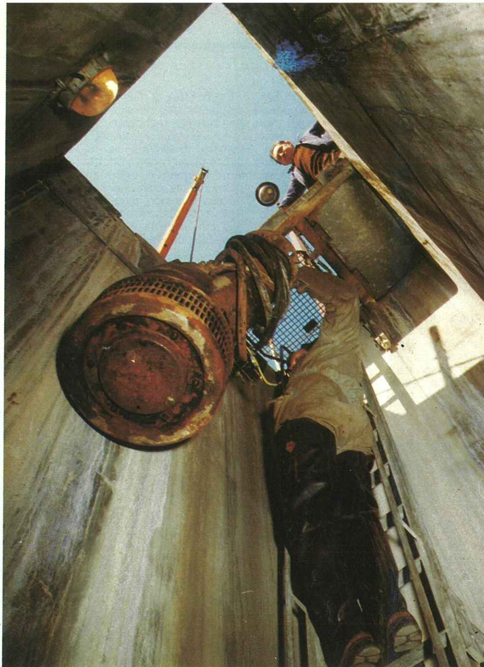
Mise en place d'une pompe dans le poste d'épuisement de la porte de Clichy.
