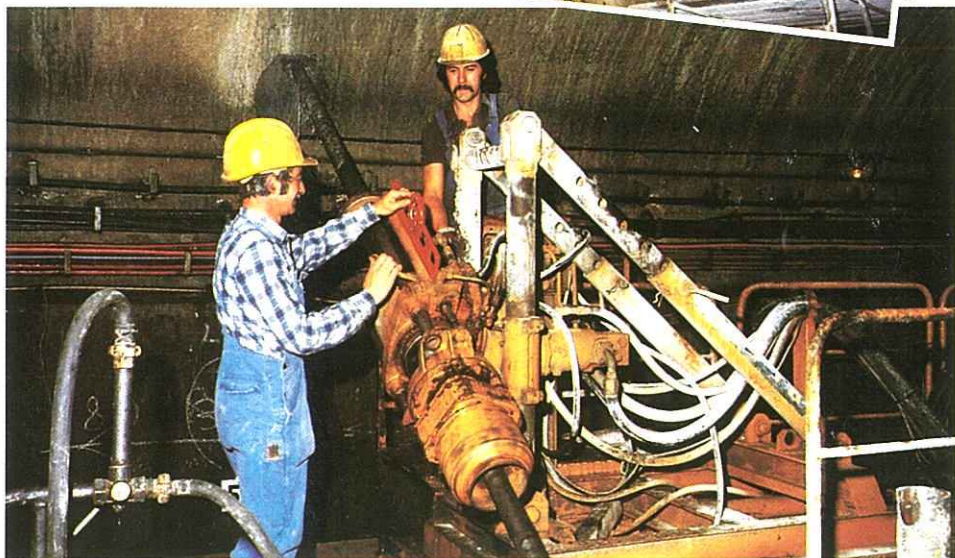
Sondage carotté en souterrain
