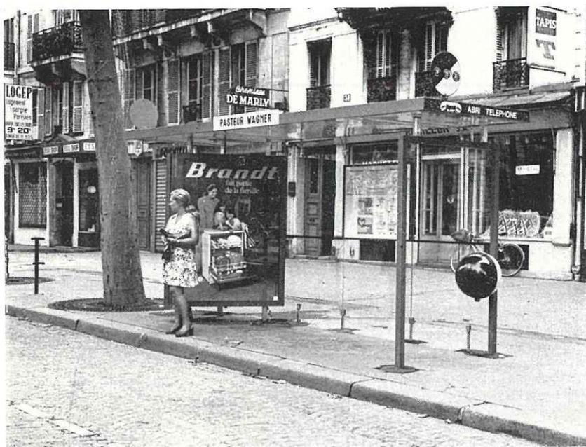
Modèle à fond transparent, installé au voisinage des magasins.
