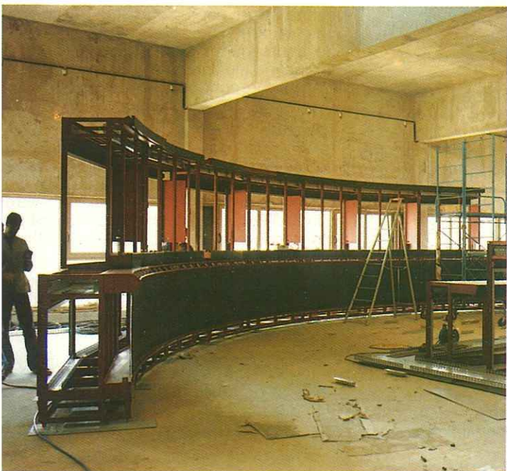
juillet 1984, le montage du tableau de contrôle optique vient juste de commencer.
