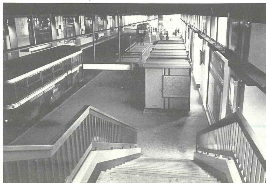
Gare routière la Défense Nord - départs.
