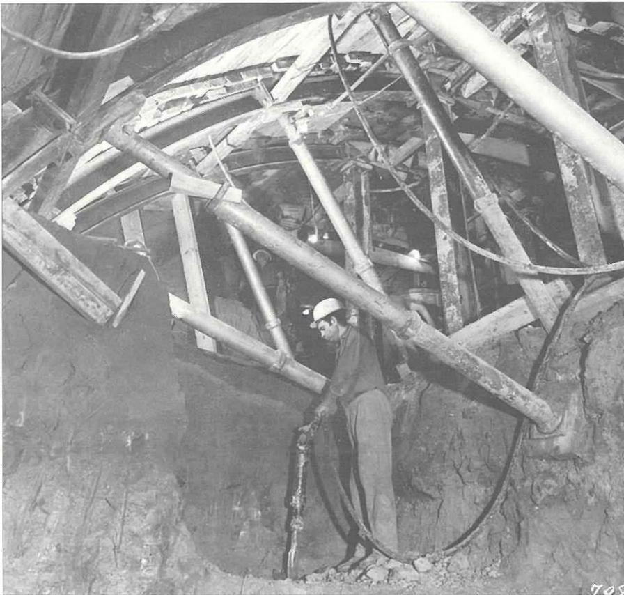
tion dans les terrains pulvérulents à fort angle de talus naturel en s'appuyant au-delà de la zone perturbée, à moins que l'on décompose le travail en galeries pilotes de faible section entièrement blindées à l'avancement, ce qui augmente considérablement le délai d'exécution et le prix de revient.
