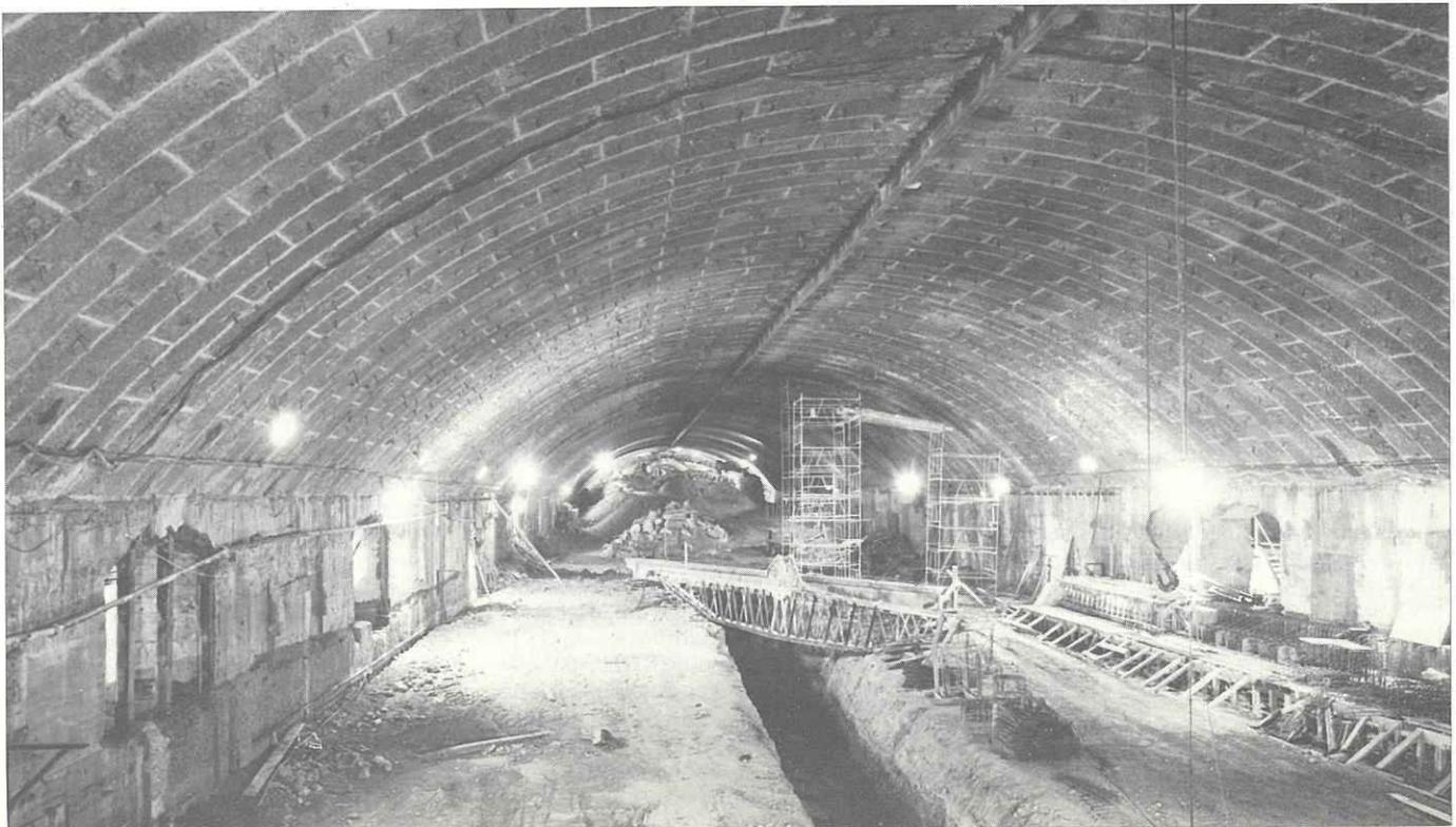
Fig. 7 - Voûte de la station Auber : arcs composés d'éléments en béton armé articulés, plaqués au terrain par la mise en compression de vérins plats, dans l'élément de clef
