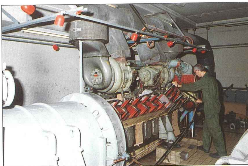
Déculassage du groupe diesel du PHT Denfert.
