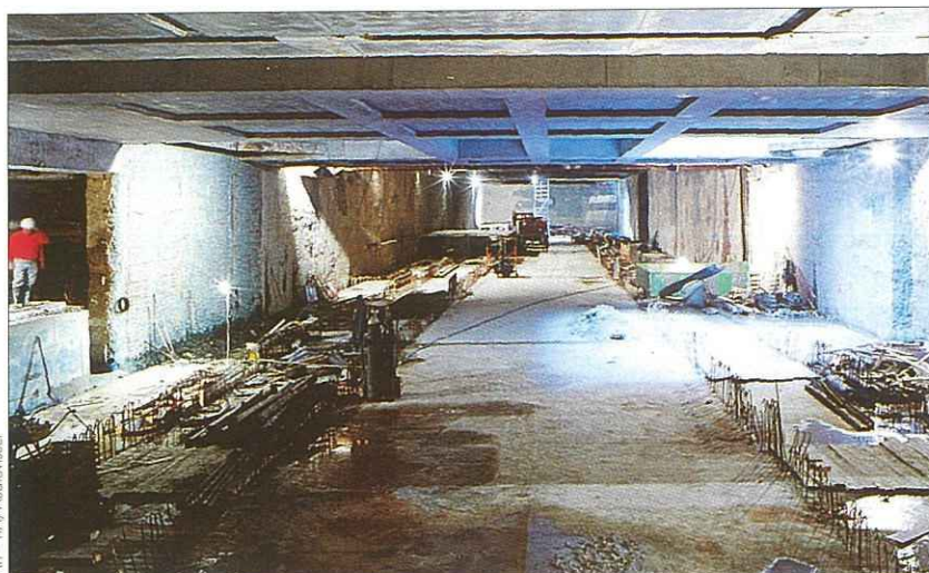
Station Bercy au niveau de la mezzanine.
