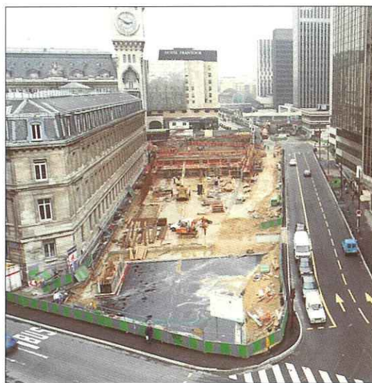
Rue de Bercy : chantier commun Météor/ligne D.
