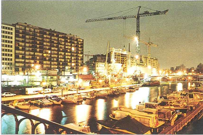
Puits Météor et ligne D au bassin de l'Arsenal.
