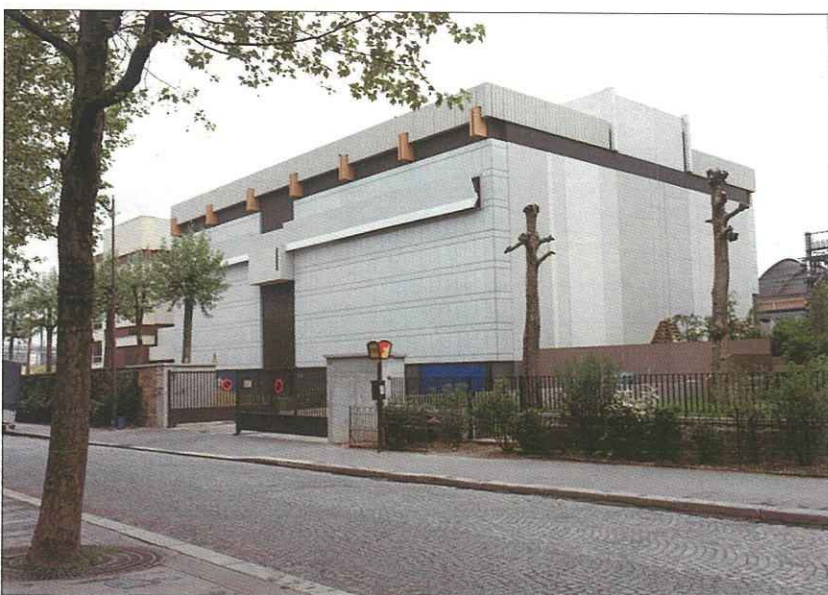
Poste Haute Tension René Coty. Deux arrivées EDF l'alimentent en 225 000 V.
