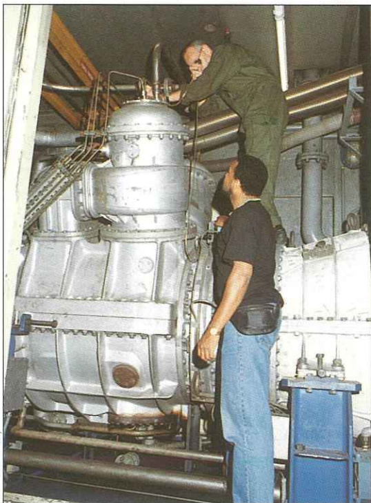
Analyse endoscopique d'une chambre de combustion du groupe à turbine à gaz du PHT Ney.
