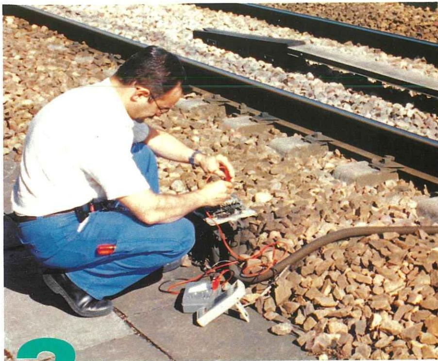
**3** S'il s'agit d'une défaillance « sol », une équipe de maintenance ESE, qui a localisé la zone concernée grâce au Mini Dam, intervient sur la balise défectueuse.
