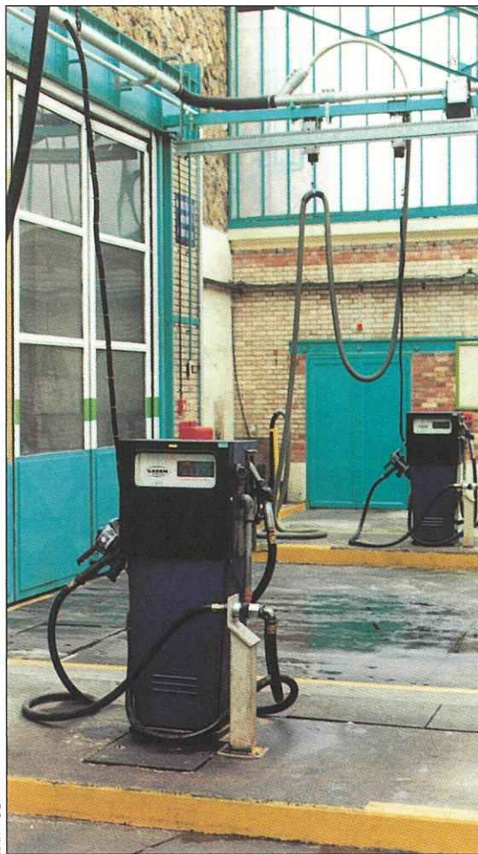
Centre bus d'Asnières : postes de charge en carburant. A droite, le pistolet standard ; à gauche, le pistolet de charge étanche.
