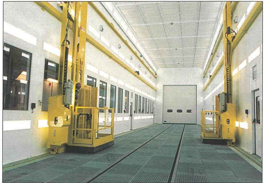
Cabine de peinture des caisses.
