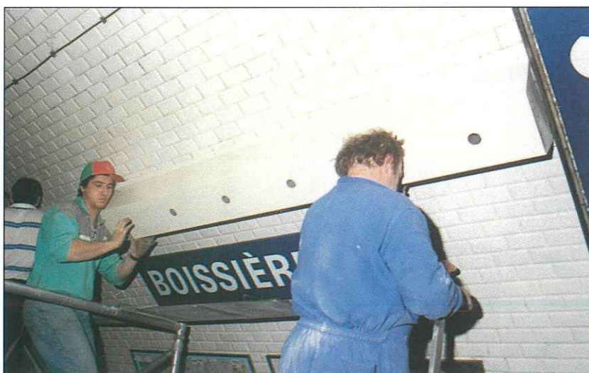
③ Fixation d'un module de 10 résonateurs.
