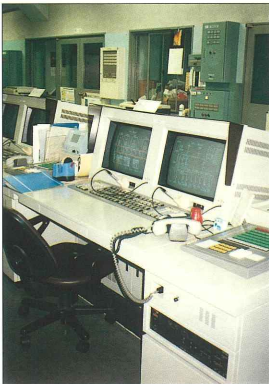
27 Nagoya - Poste de commande de l'énergie. Pupitre de télécommande de l'alimentation de la ligne 6. Console informatique avec visualisation du schéma et commande par crayon optique (réseau à fibres optiques).
