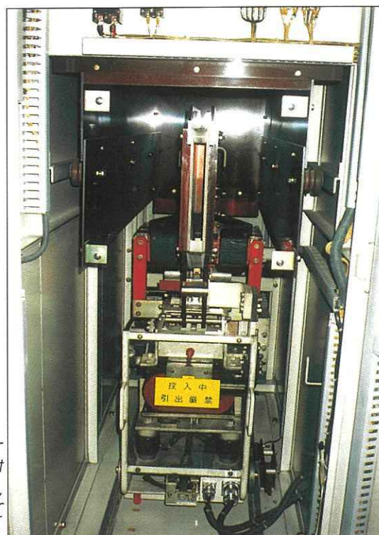
18 Tokyo - Disjoncteur à courant continu type JRM, 3000-4000 A, PCC 50 kA 20 ms.
