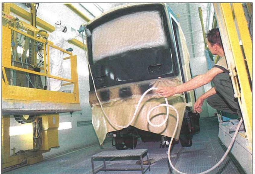
Préparation de mise en peinture d'une voiture de métro.
