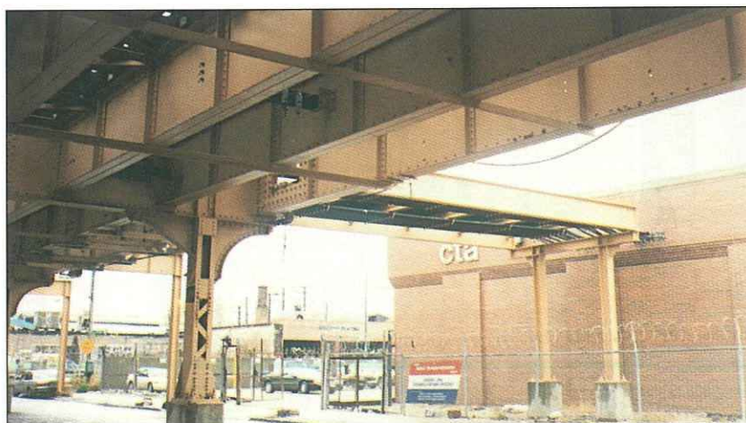
⑪ Chicago - Sous-station Pulaski - 2 x 2500 kW. Le bâtiment de la sous-station est à droite avec son câblage vers le viaduc pour l'alimentation traction des voies.
