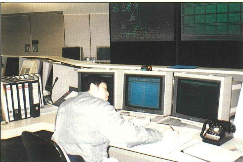
41 Hong Kong - Central Environment Control. Système Overview. Poste de surveillance de la climatisation.
