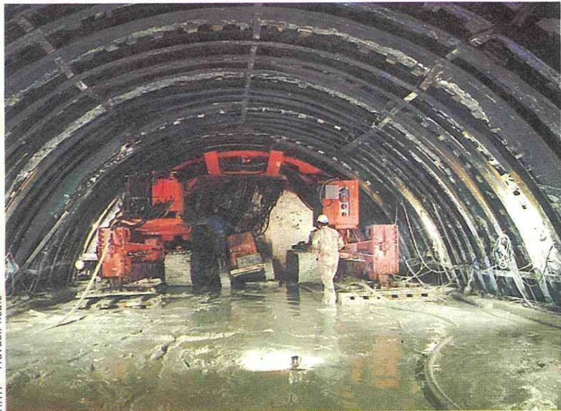
Prolongement de la ligne 10 « Austerlitz-Porte d'Auteuil » à Boulogne : puits d'attaque du tunnel.
