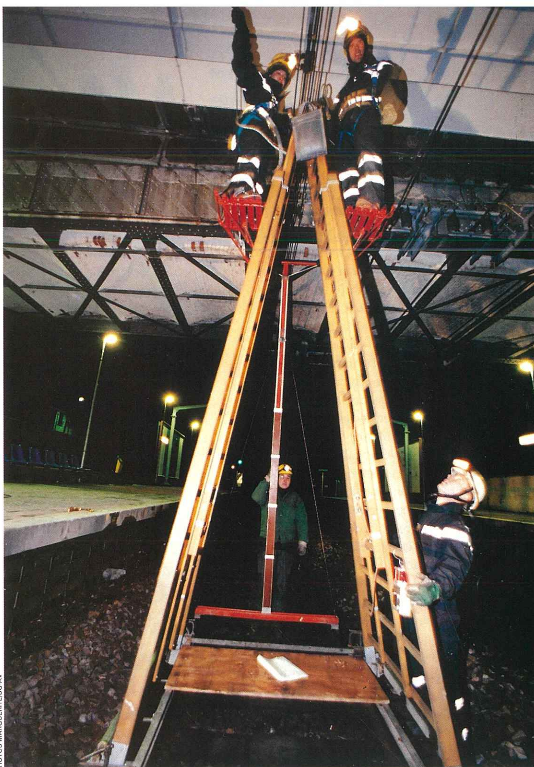
Après avoir installé le lorry tours de 400 kilos, les quatre caténaïrstes s'activent. En haut, Thierry Choquet et Frédéric Thillay, sous l'œil vigilant de Nicolas Barranca et de Serge Savary.
