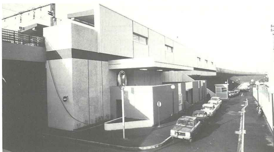
RATP - Travaux Neufs
