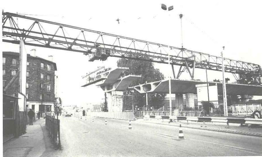
RATP - Travaux neufs
