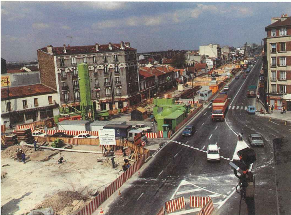
Vue du chantier en avril 1984 : la centrale d'injection sur la place du 8 Mai 1945 et les emprises du prolongement sur la RN 2.
