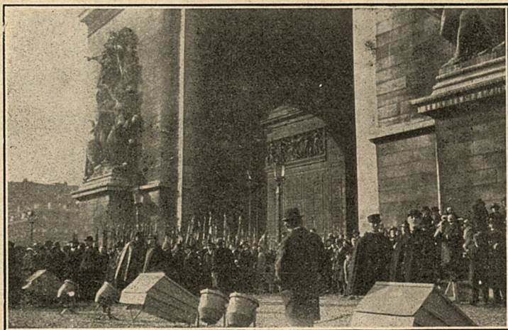
A la tombe du soldat inconnu; on aperçoit au premier plan les projecteurs qui éclairèrent l'Arc de Triomphe dans la nuit du 10 au 11 Novembre.
