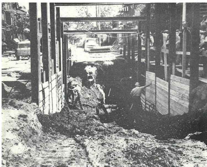
Fig. 11. — Entrée de chantier de construction du tunnel (en pente 20 %)
