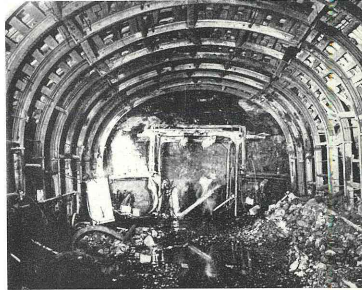
Fig. 3. — Le roc est généralement solide et tient en place. Une faible partie a dû être ici renforcée
