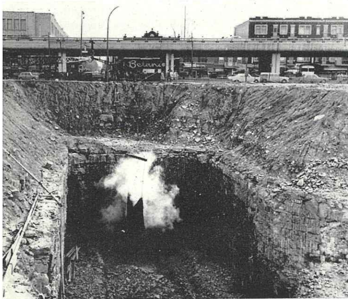
Fig. 13. — Excavation par explosif à ciel ouvert de la station « Crémazie »
