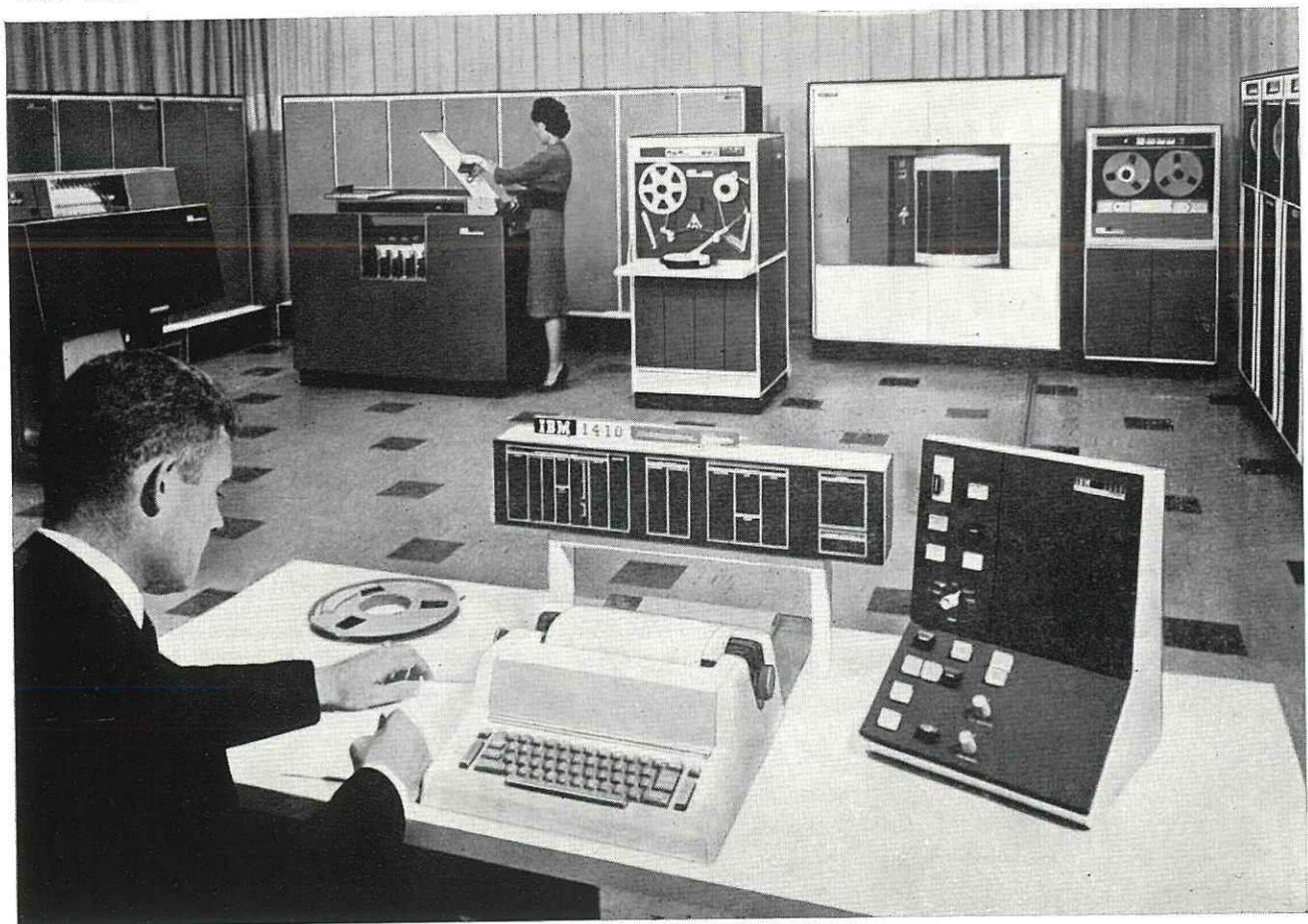
Fig. 17. — Ensemble 1410. De gauche à droite : imprimante, lecteur de cartes, unité centrale, unité à bande 730, unité à disques, unité à bandes 730 et 729. Au premier plan, le pupitre.
