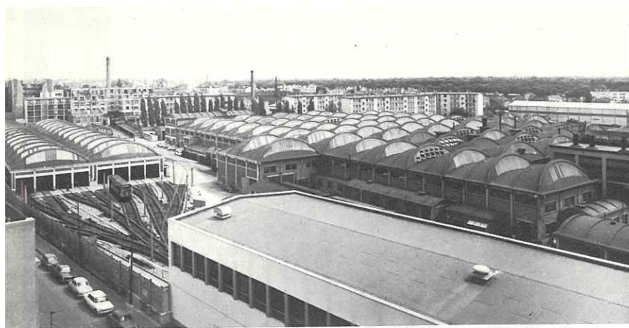
Fig. 51. — Vue générale d'un grand atelier. A gauche, le hall d'entretien, à droite, les ateliers de révision.
