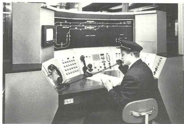
Fig. 40. — Poste de manœuvre de terminus avec tableau de contrôle optique.
