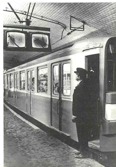
Fig. 16. — Surveillance de la montée des voyageurs par télévision.
