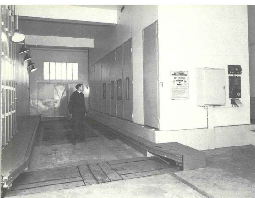
Fig. 47. — Poste de redressement.
