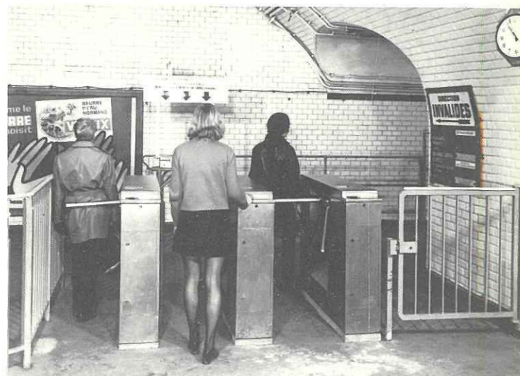
Fig. 24. — Essai de tourniquet d'admission automatique.
