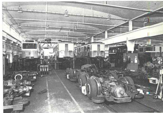
Fig. 52. — Atelier de levage et de révision des voitures.
